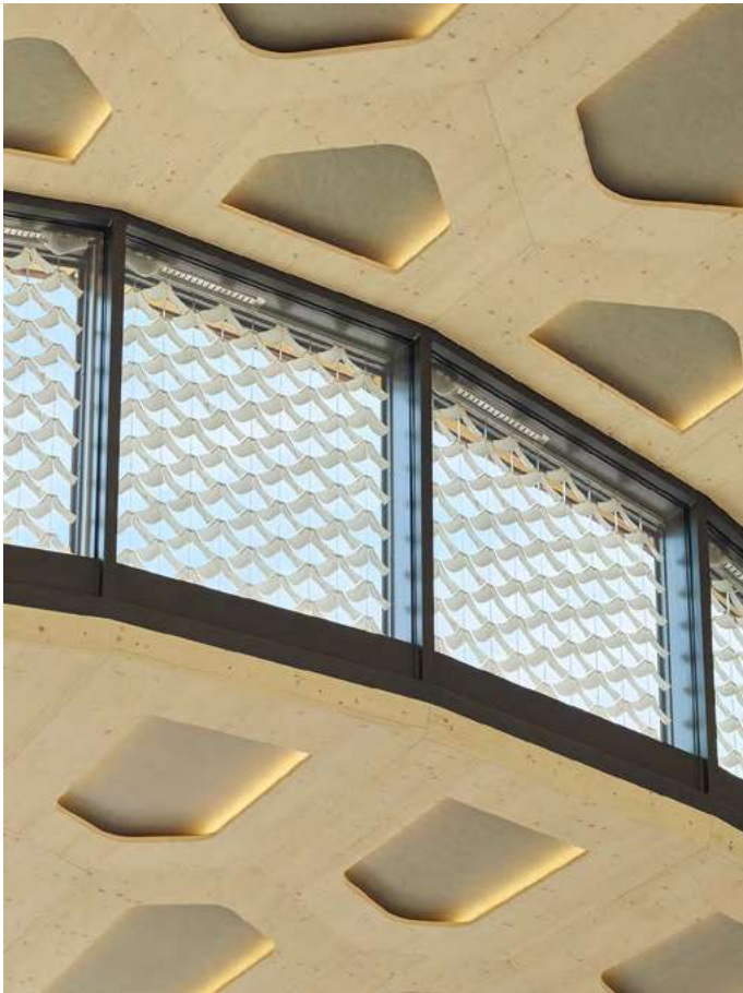
Abb. 5: Fassadenelement aus dem 3D-Drucker
