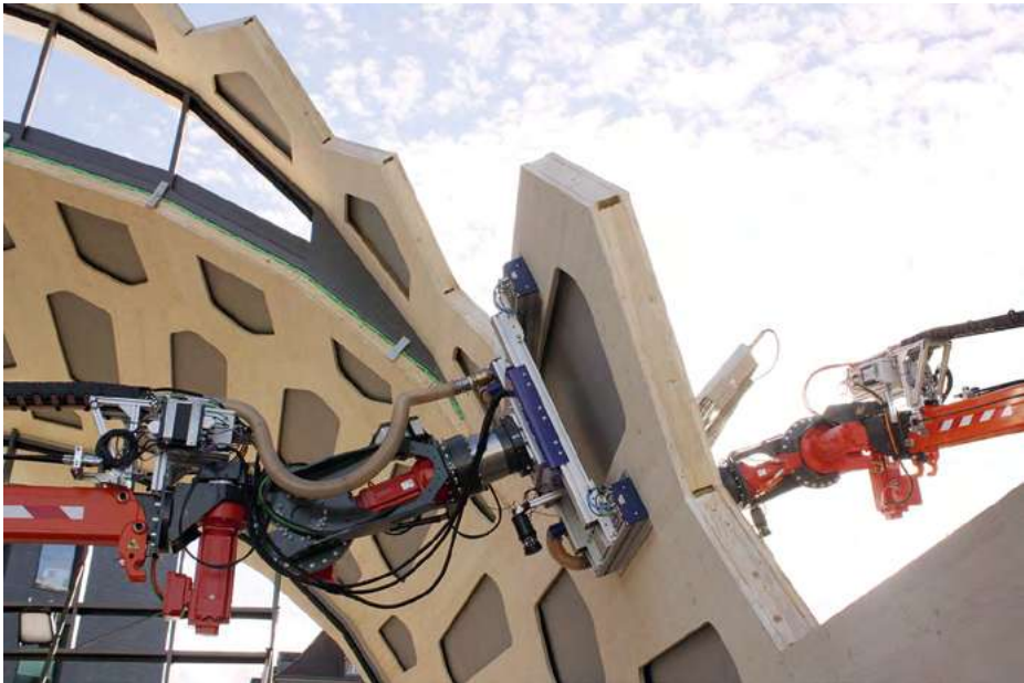
Abb. 4: robotische Montage
