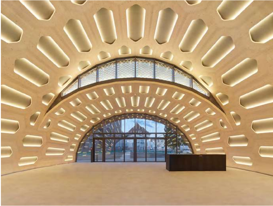
Abb. 3: Holzsegmentschalenkonstruktion für die Universität Freiburg
