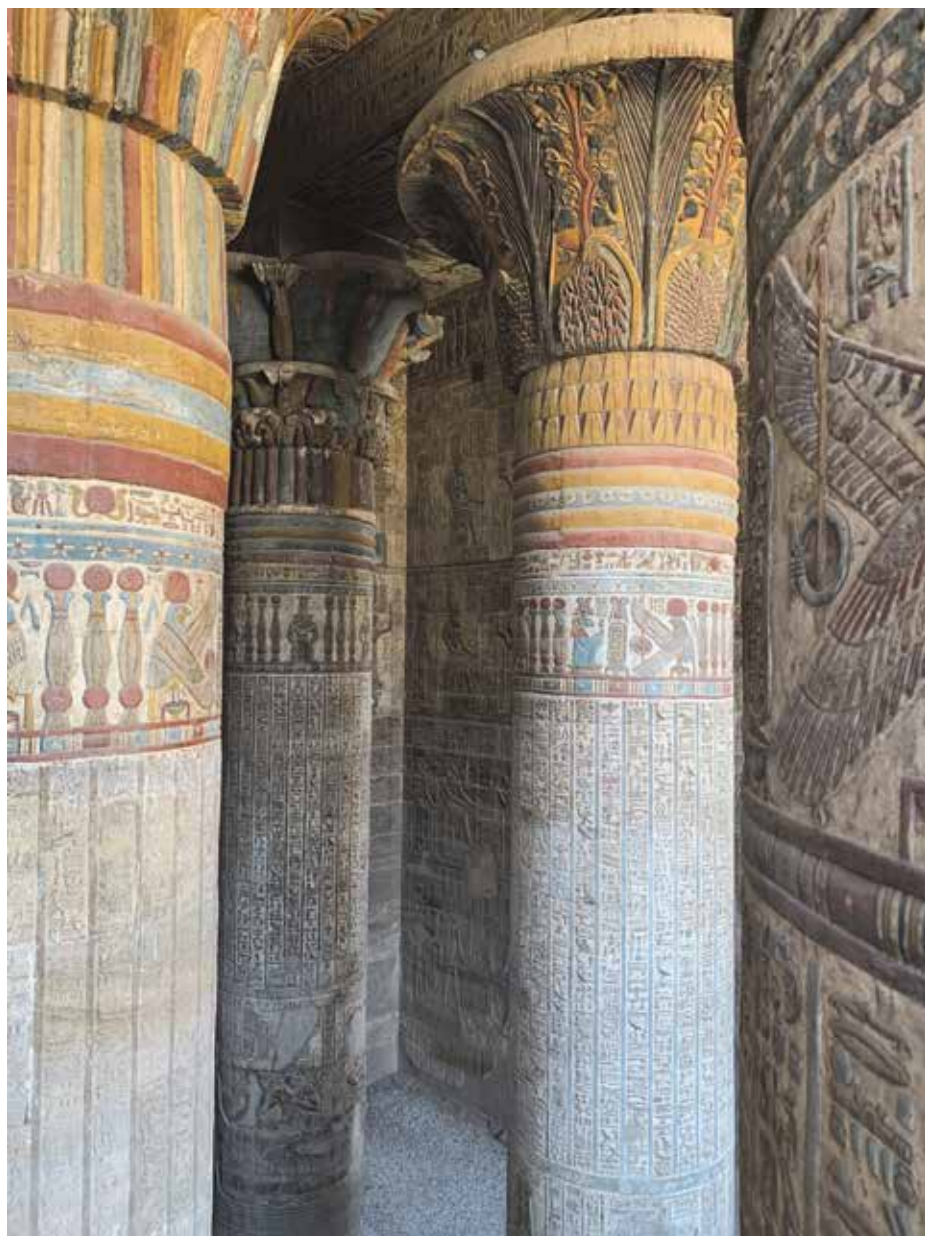
Abb. 2: Ansicht der fertig restaurierten Säulen der nördlichen Hälfte des Pronaos, Foto: Mendel-Leitz 4012
